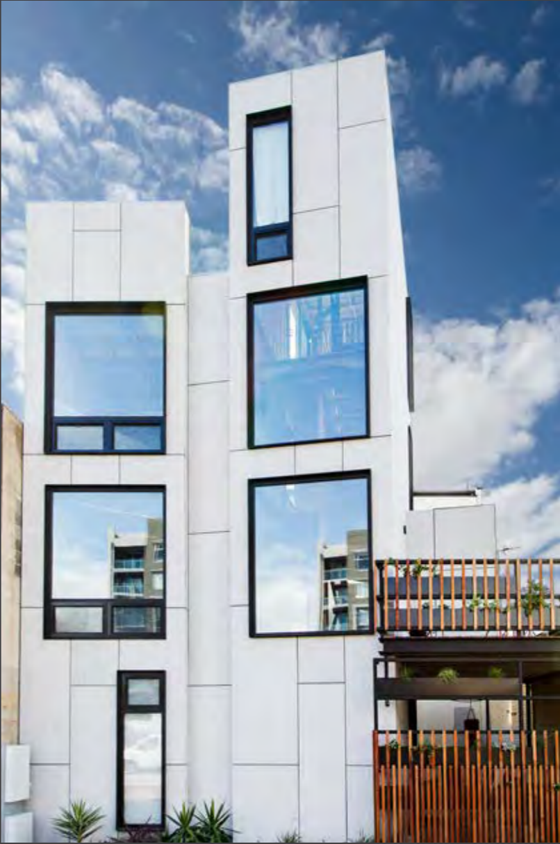
Architect: Damian Chwalisz. Builder: Robert van Gorp.
